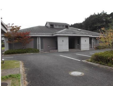
40.和東中央浄化センター
