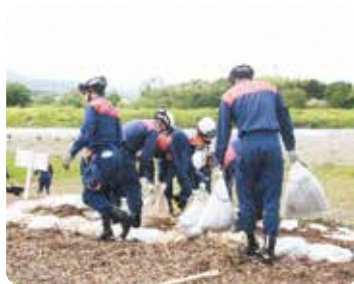
積土のう工法
