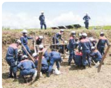
杭打ち積土のう工法
