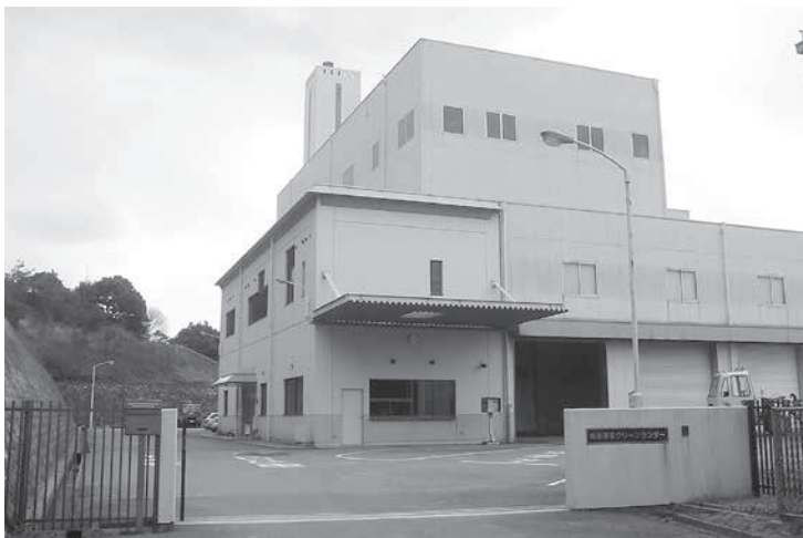
老朽化の進むクリーンセンター
