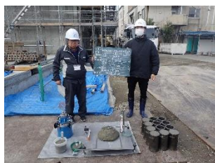
コンクリート受入検査
