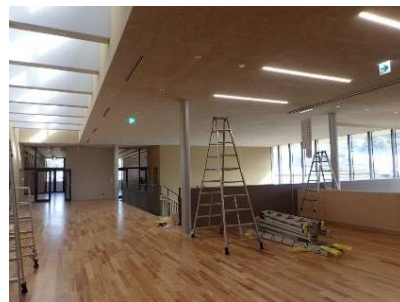
内部2F吹抜状況
