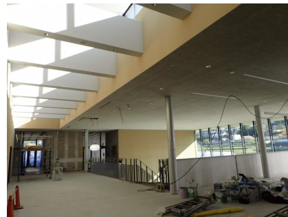
内部2F吹抜状況
