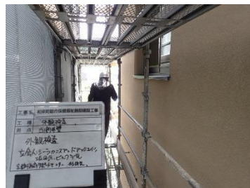
外観検査状況
