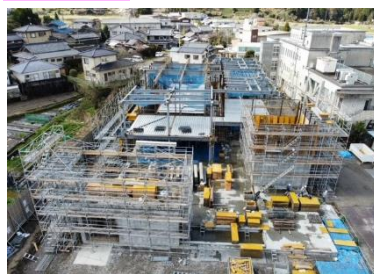
東工区 施工状況(RC躯体工事)
