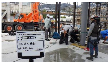
鉄骨建て方検査
