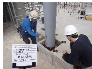
鉄骨鉛直精度検査
