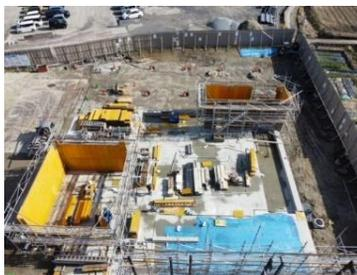
コンクリート造1階の壁型枠・鉄筋工事を行っています。
