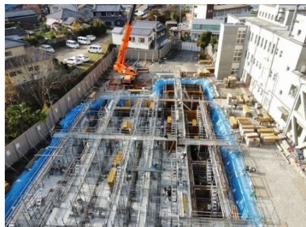
西工区 施工状況(型枠)
