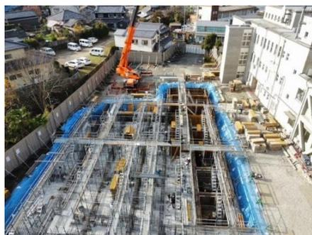
コンクリートを流し込むために必要な型枠を木で組み立てています。
