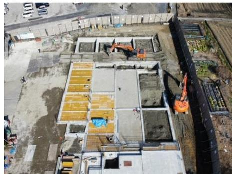
基礎を埋戻し1階床スラブ工事の準備をしています。
