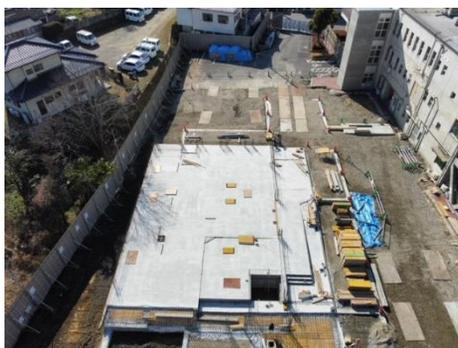
1階床スラブコンクリート打設が完了しました。
