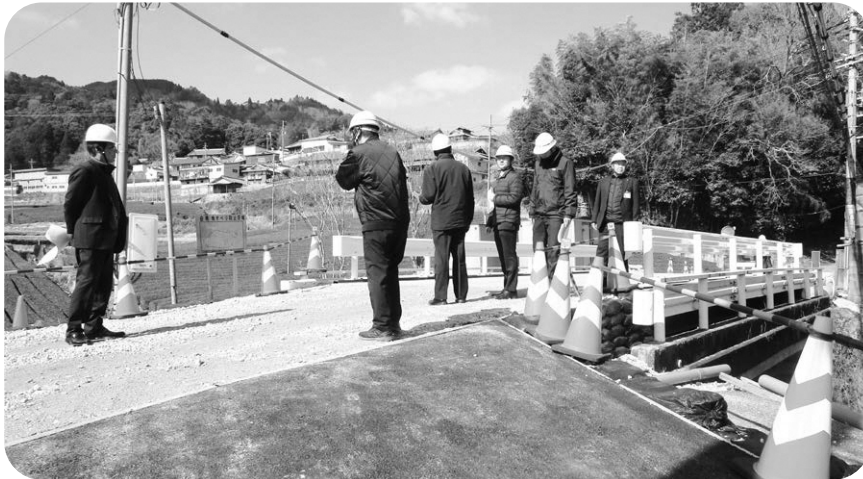
橋梁補強工事現地調査
