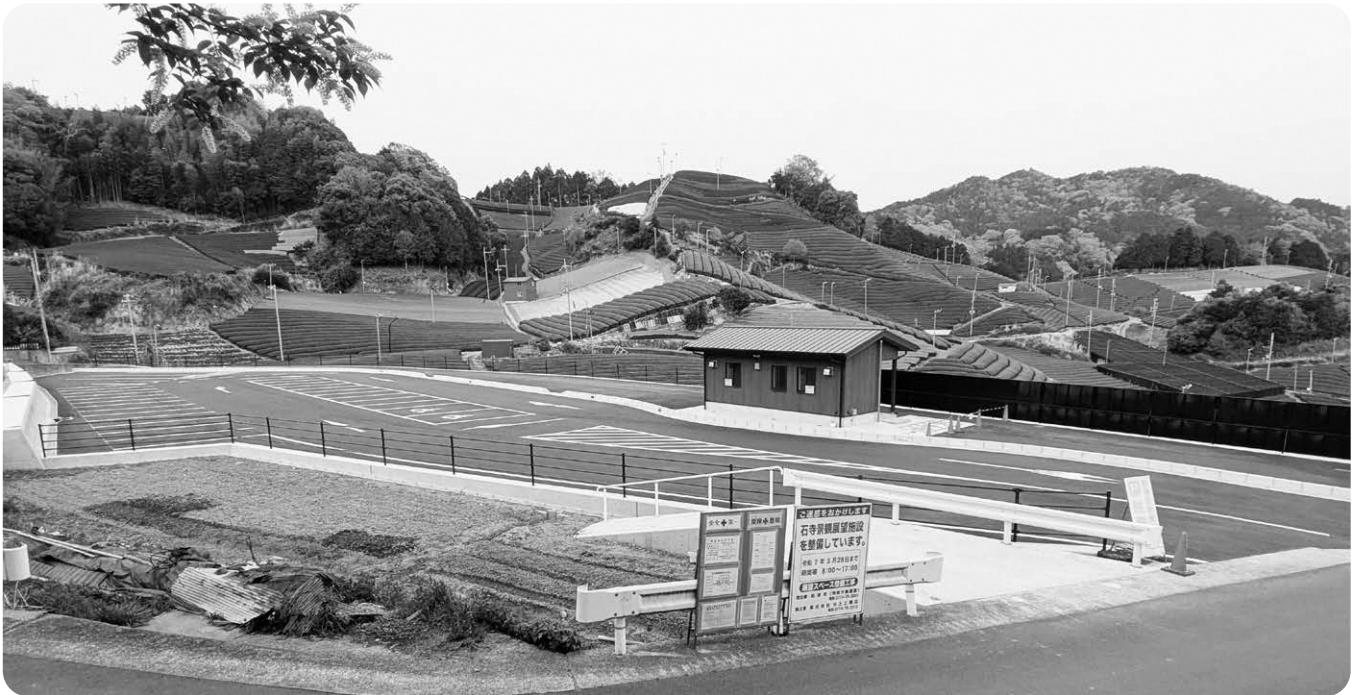
石寺景観駐車場
