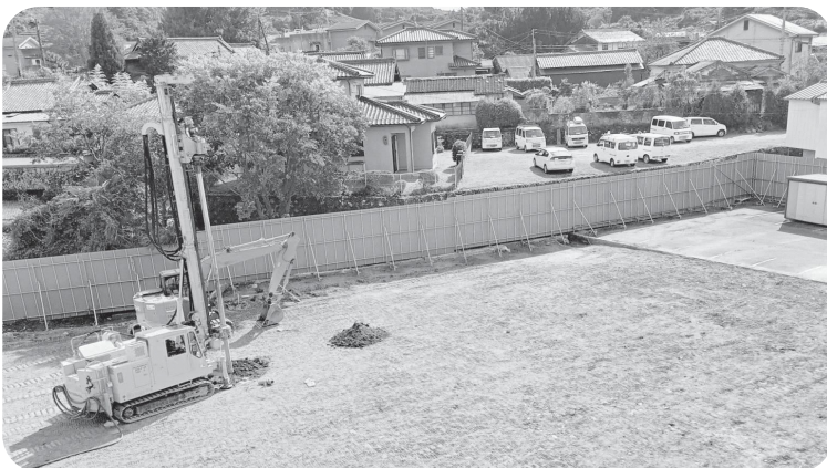
工事が始まった総合保健福祉施設
