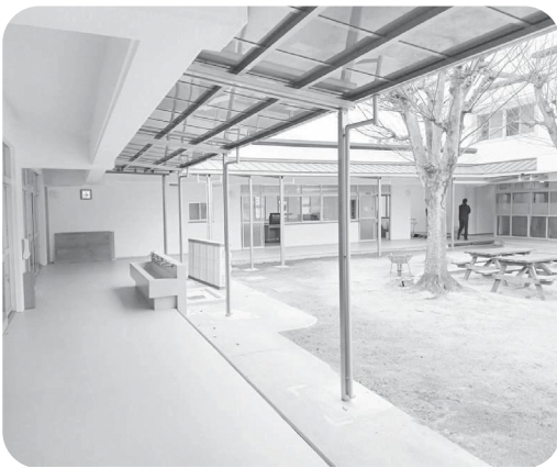
耐震改修を終えた保育園
