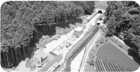
工事が進む(仮称)犬打峠トンネル
