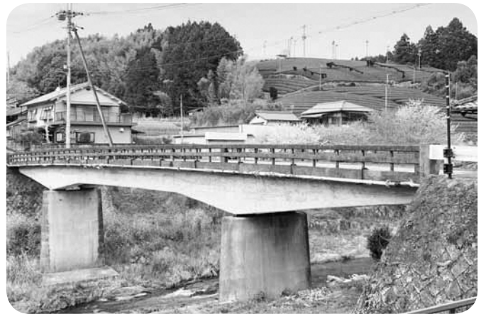
架け替えに着手する石寺橋
