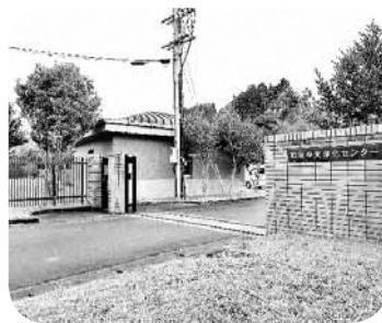
和東中央浄化センター
