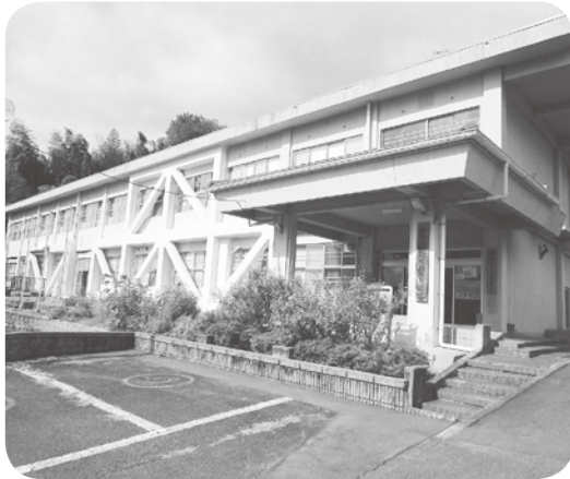
体験交流センター耐震改修
