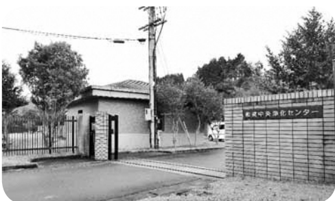
和東中央浄化センター
