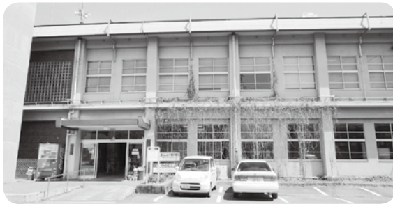
解体される社会福祉センター
