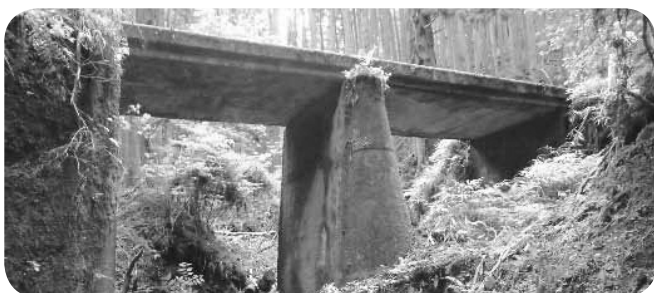
修繕される丸尾二橋(町道童仙房支線)
