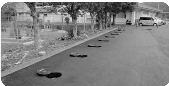
和東小学校にマンホールトイレ設置
