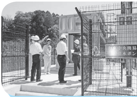
和東中央簡易水道木屋送水ポンプ所
