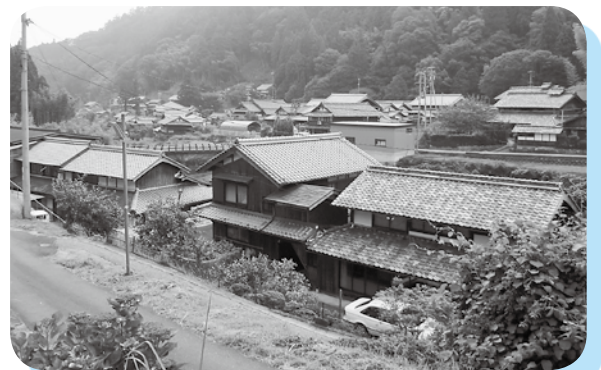
伝統的建造物群を調査(湯船地区)
