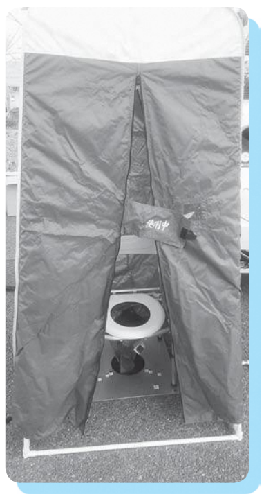
災害用マンホールトイレ (長岡京市)
