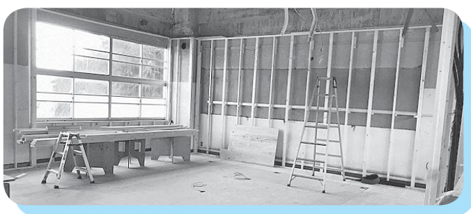
整備が進む体験交流センター
