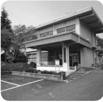
耐震補強される体験交流センター
