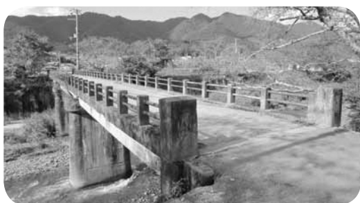
新設される中区祝橋
