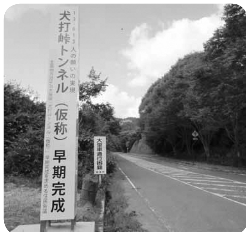
犬打峠トンネル早期完成標柱設置
