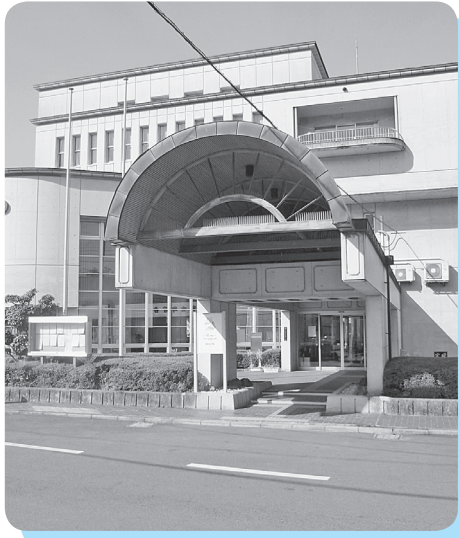
耐震改修される和東町庁舎
