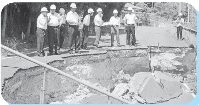
地すべりがおこった現地調査（別所地内）
