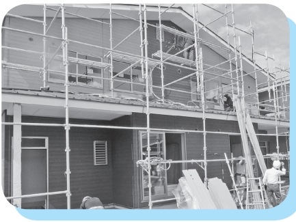
建替中の第5中西団地
