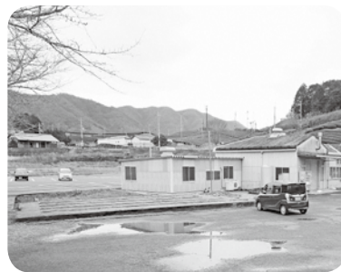
ガラスハウスを撤去
