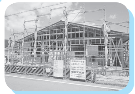
町営住宅第3中西団地工事中
