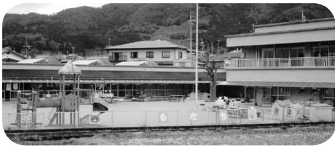
耐震改修される和東保育園
