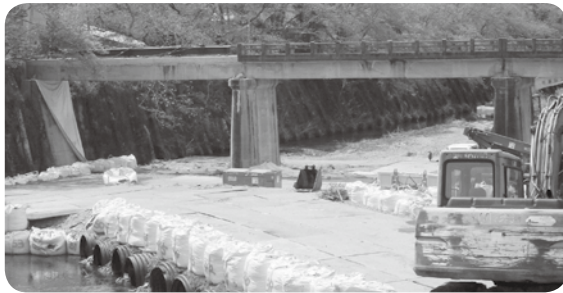
工事が始まった祝橋
