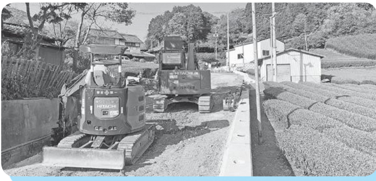
工事中の町道山口線(原山地内)
