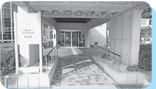
改修された庁舎玄関スロープ
