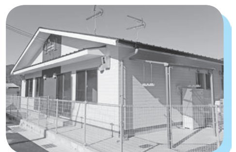
昨年10月完成の町営第3中西団地
